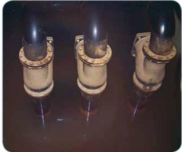
Le valvole a saracinesca a ghigliottina, con comando a volantino, ricoprono varie funzioni e vengono usate come organi di intercettazione per regolare il flusso in una tubazione o isolare temporaneamente un settore di impianto.
