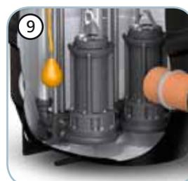
Installazione dell'elettropompa con piede d'accoppiamento fissato al fondo tramite viti con guarnizione a tenuta ermetica e barre di rinforzo in acciaio. Sistema start/stop e di allarme anti tracimazione tramite galleggianti.
