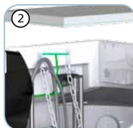
Collegamento a terra di ogni elemento metallico all'interno della stazione di sollevamento tramite rete equipotenziale.
